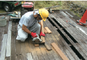
腐食したデッキ材を取り外し、新しい木材で補修工事。
